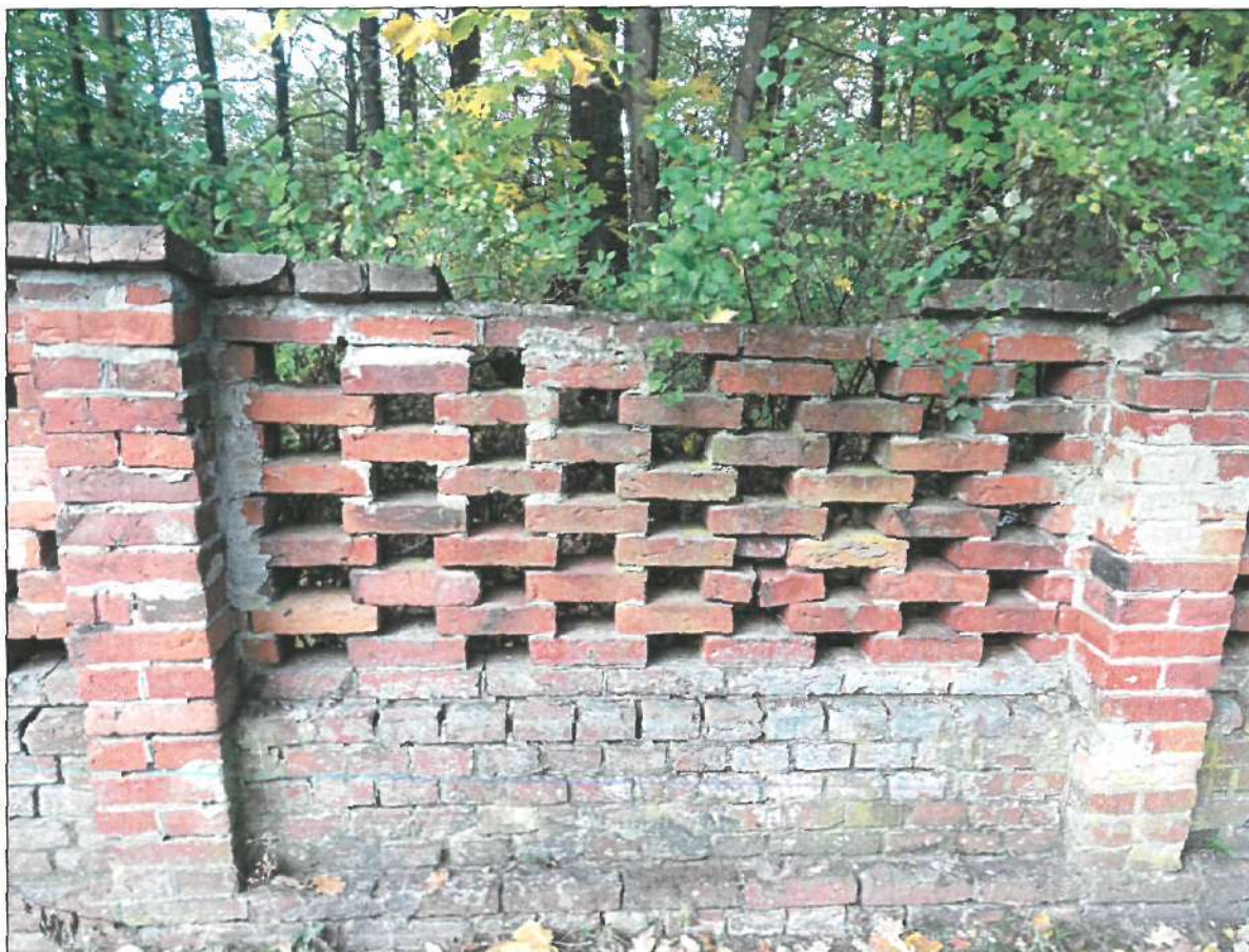
FRAGMENT MURU - ODCINEK C-D. Widoczne aktywne formy biologiczne na cegle - glony i porosty. Ubytki cegieł w murze, brak fragmentu czapki. Ślady napraw zaprawą cementową.
