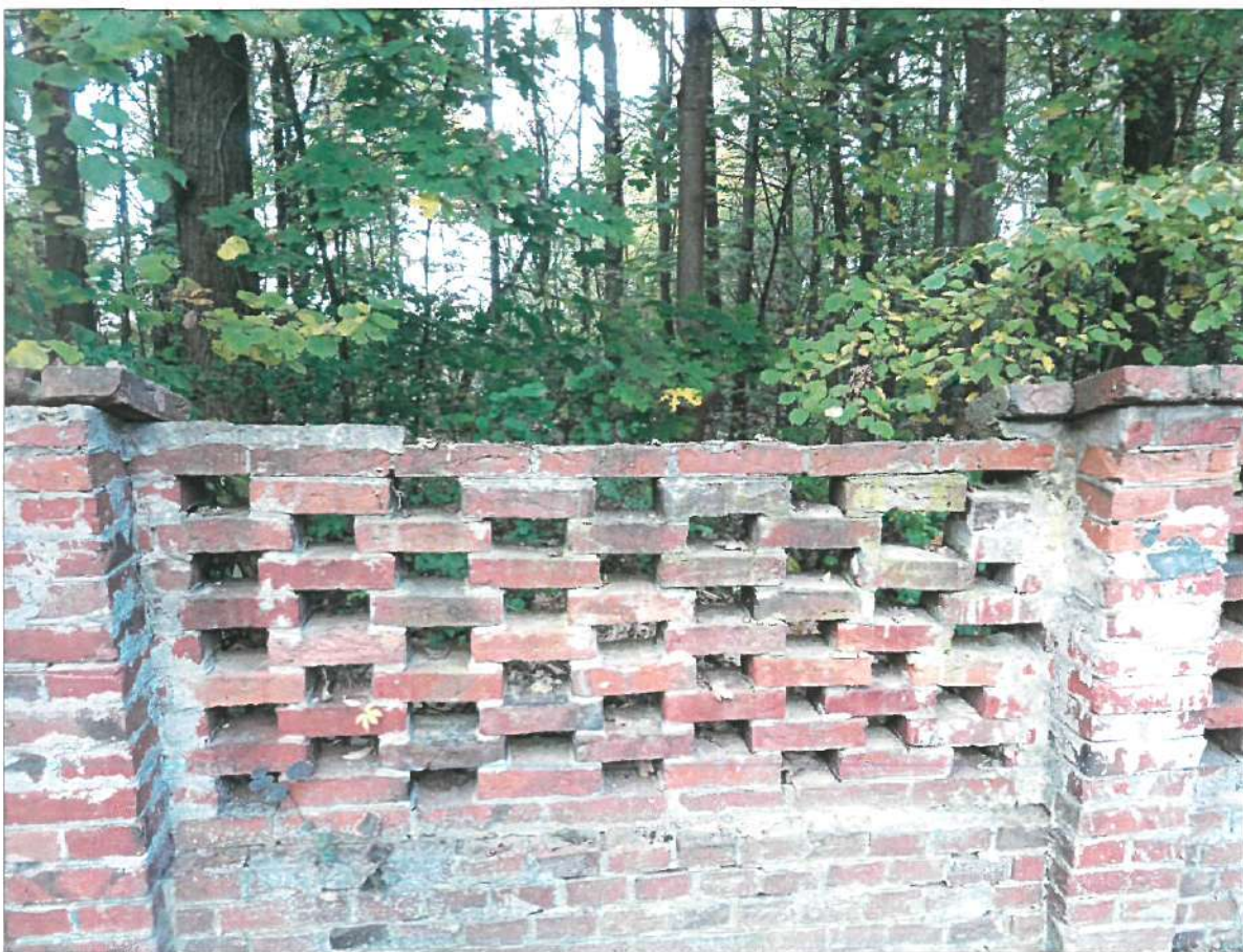
FRAGMENT MURU - ODCINEK C-D. Widoczne aktywne formy biologiczne na cegle - glony i porosty. Ubytek czapki muru na przęśle. Ślady napraw zaprawą cementową.
