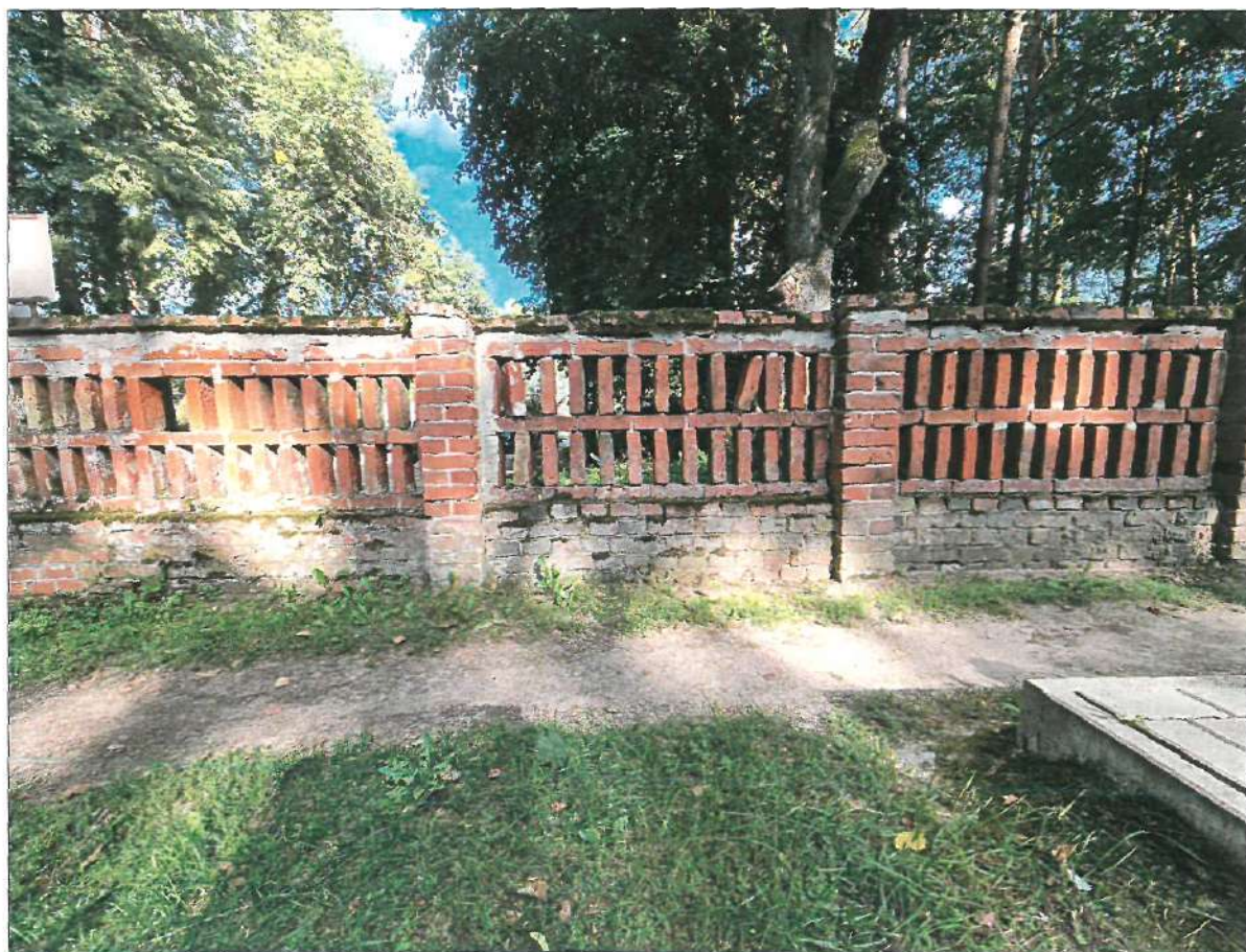
FRAGMENT MURU - ODCINEK A-D. Widoczne aktywne formy biologiczne na cegle - mchy. Odchylenie muru od pionu na odcinku 6 przesz. Ubytki cegieł w murze. Ślady napraw zaprawą cementową.
