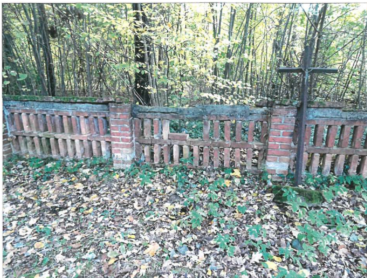
FRAGMENT MURU - ODCINEK A-B. Widoczne aktywne formy biologiczne na cegle - glony i porosty. Ubytki cegieł w murze, brak czapki. Ślady napraw zaprawą cementową. Wysoki poziom nasypu gruntu od strony cmentarza.
