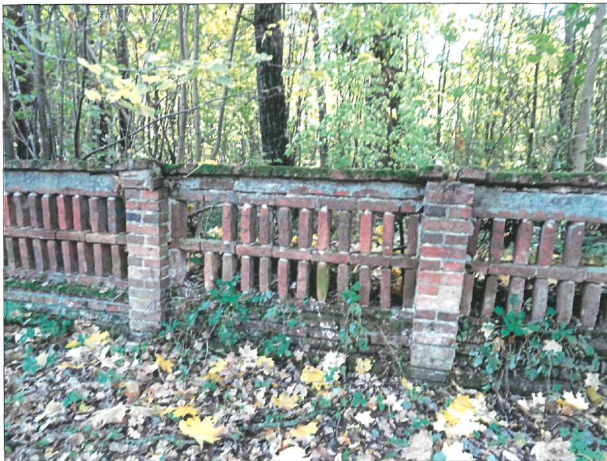
FRAGMENT MURU - ODCINEK A-B. Widoczne aktywne formy biologiczne na cegle - glony i porosty. Ubytki cegieł w murze. Ślady napraw zaprawą cementową. Wysoki poziom nasypu gruntu od strony cmentarza.
