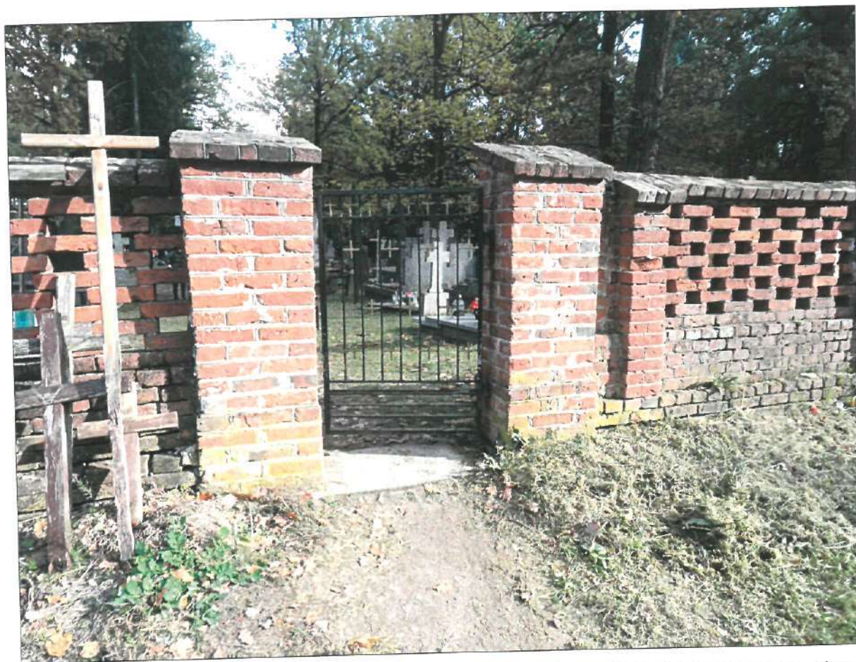
SZCZEGÓŁ FURTKI - ODCINEK B-C. Widoczne aktywne formy biologiczne na cegle - glony i porosty. Ubytki cegieł w murze. Furtka wymagająca renowacji.
