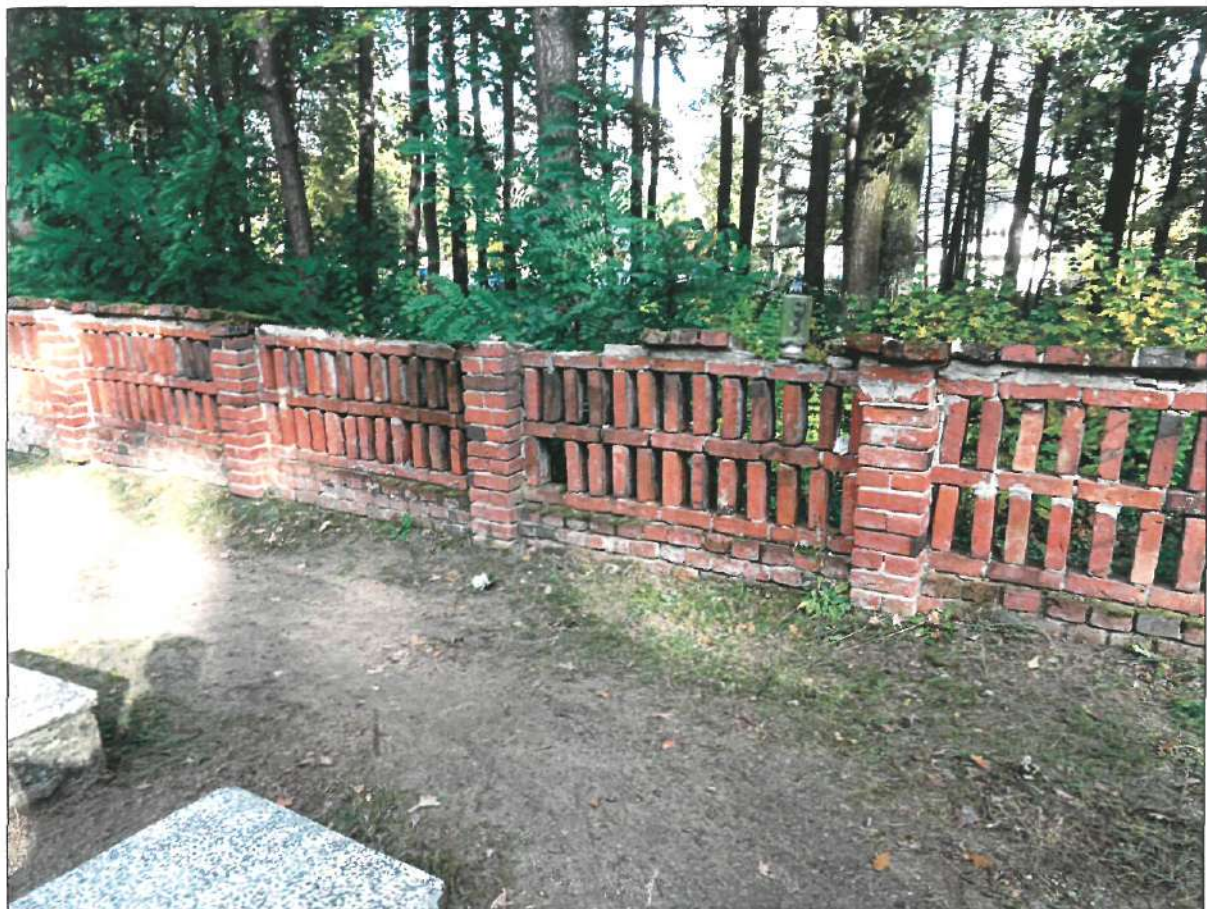
WEWNĘTRZNY WIDOK OGRODZENIA - ODCINEK A-D. Widoczne ślady napraw muru zaprawą cementową. Aktywne formy biologiczne na cegle. Ubytek cegieł na czapkach przęseł. Podniesiony poziom terenu od strony cmentarza.
