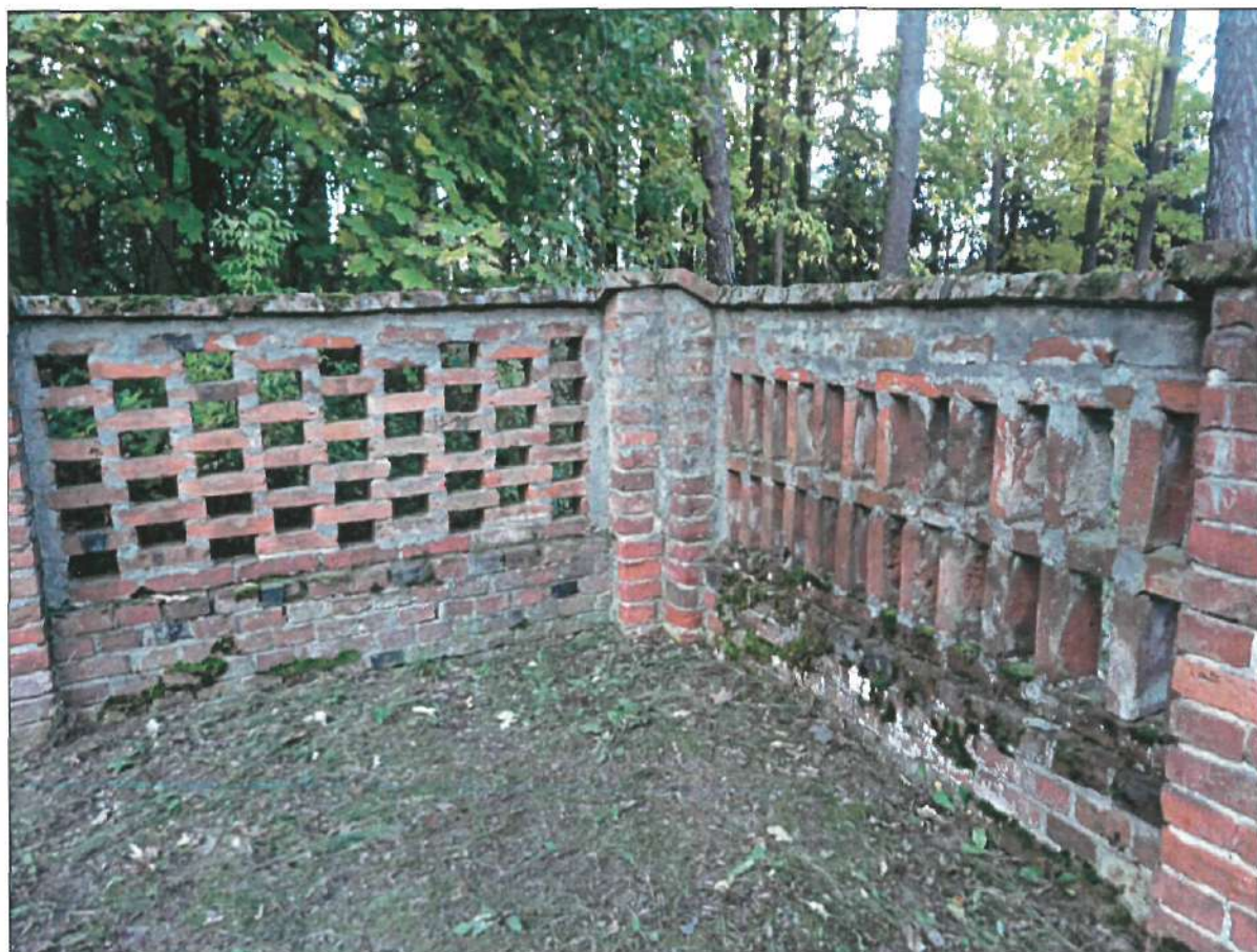
WEWNĘTRZNY WIDOK NAROŻNIKA "D" OGRODZENIA. Widoczne ślady napraw muru zaprawą cementową. Aktywne formy biologiczne na cegle.
