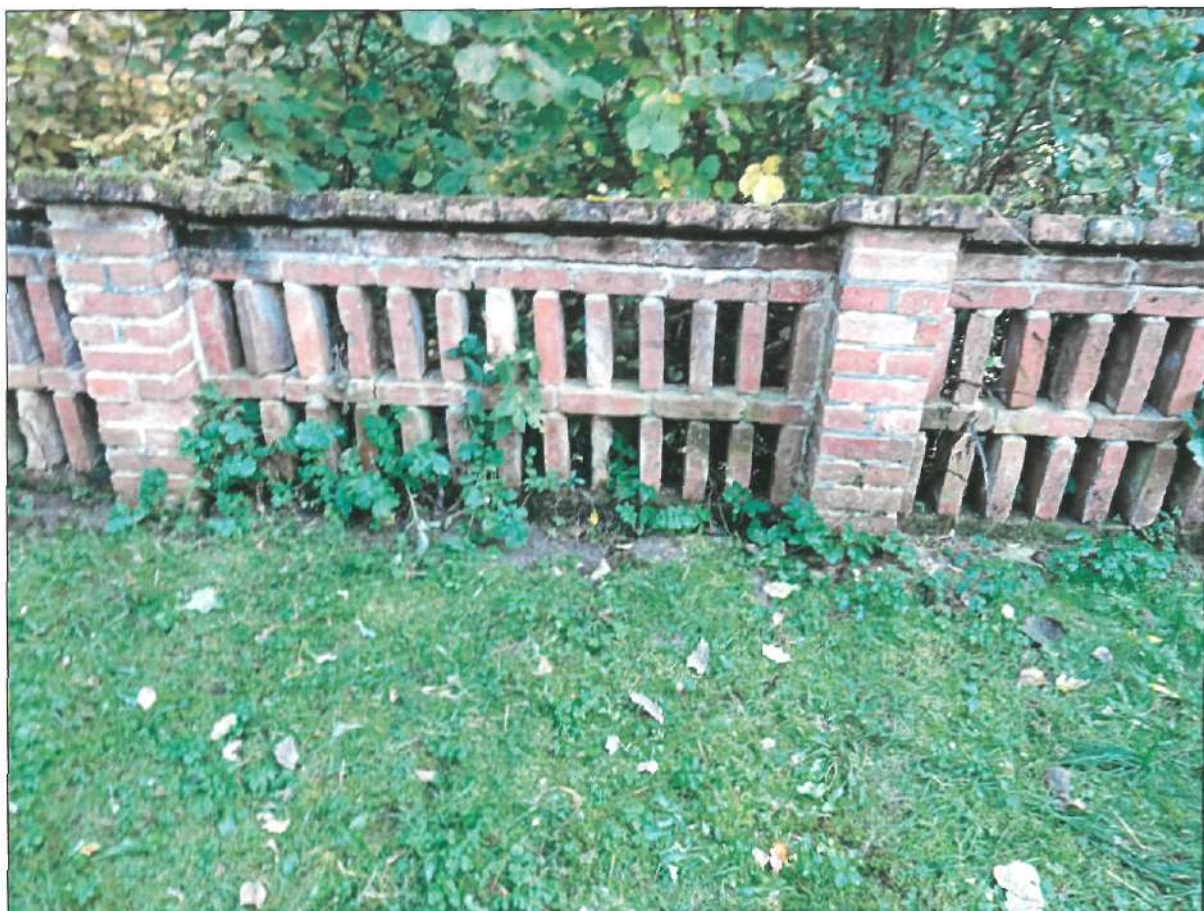
FRAGMENT MURU - ODCINEK A-B. Widoczne aktywne formy biologiczne na cegle - glony i porosty. Wysoki poziom nasypu gruntu od strony cmentarza.
