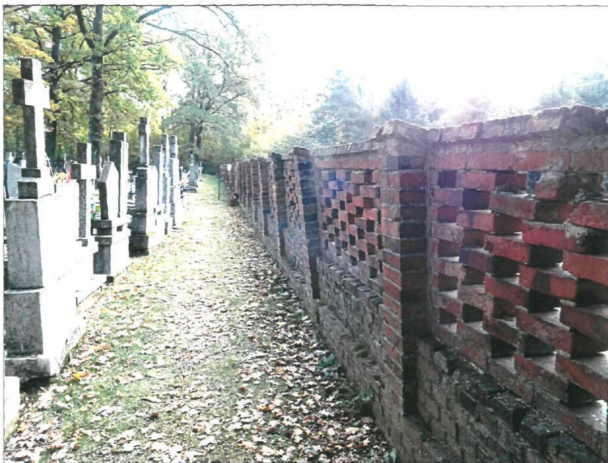
FRAGMENT MURU - ODCINEK B-C. Znaczne odchylenie muru od pionu na odcinku 8 przesz. Widoczne aktywne formy biologiczne na cegle - glony i porosty.
