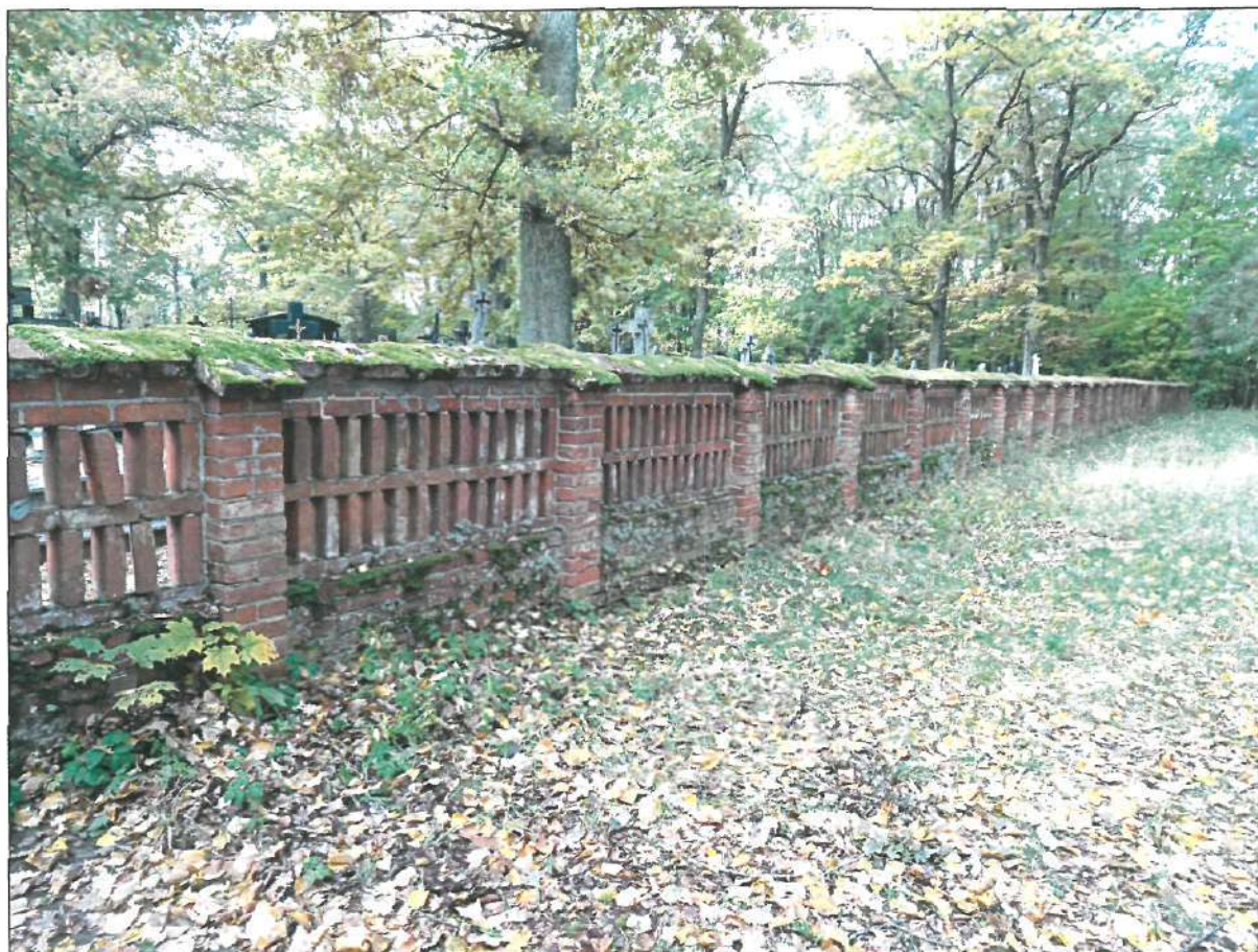
FRAGMENT OGRODZENIA OD ZEWNĄTRZ - ODCINEK A-D. Widoczne ślady aktywnych form biologicznych w postaci glonów i mchów.
