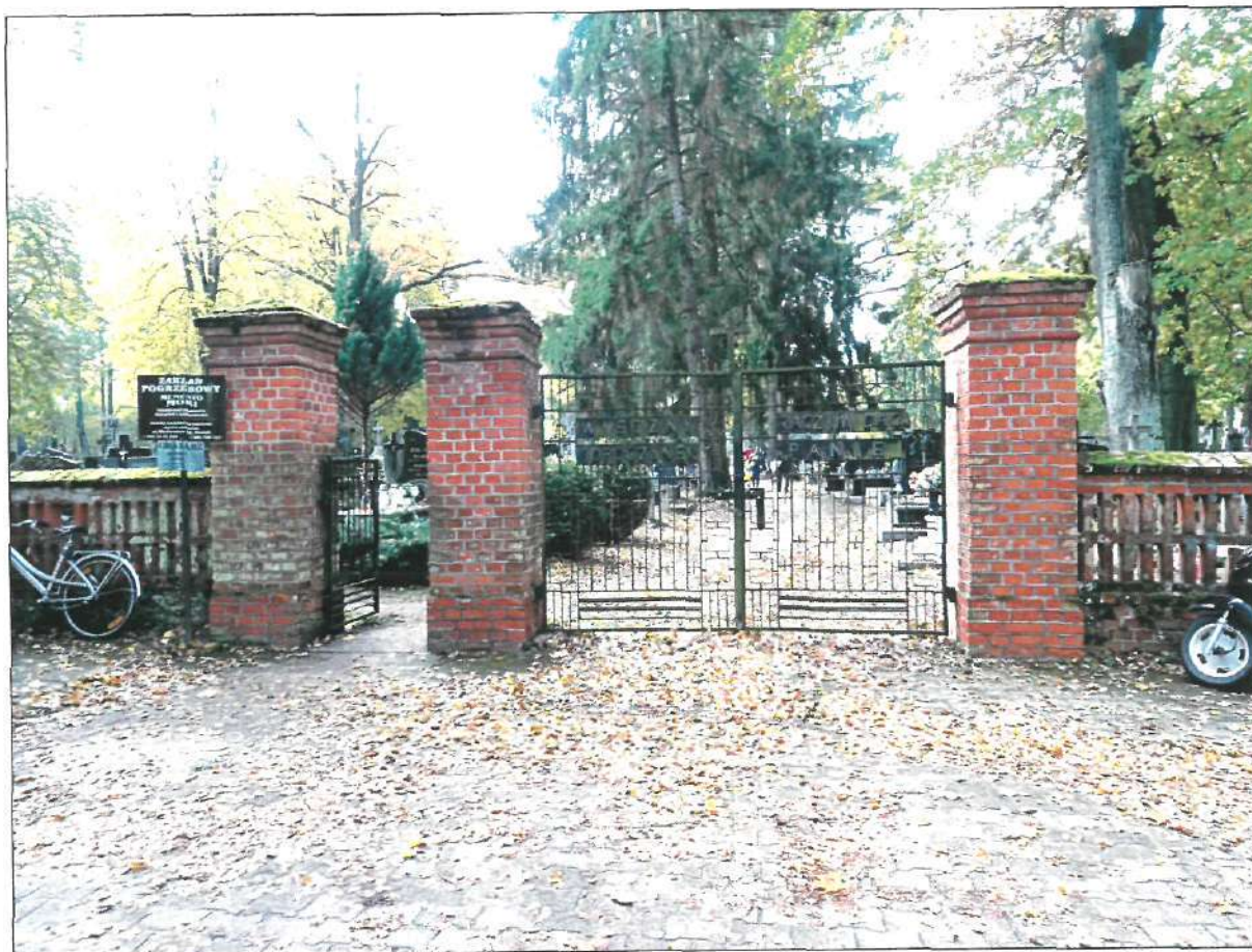
BRAMA GŁÓWNA Z FURTKĄ - ODCINEK A-D. Widoczne ślady aktywnych form biologicznych w postaci glonów i mchów. Korozja czapek słupów bramy. Elementy stalowe wymagają renowacji.
