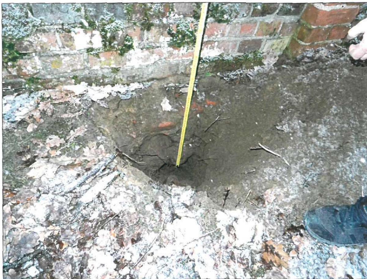
ODKRYWKA FUNDAMENTU PRZY NAROŻNIKU D. Szerokość fundamentu - 40 cm. Pierwszą warstwę stanowią cegły. Poniżej kamienie na zaprawie wapiennej.
