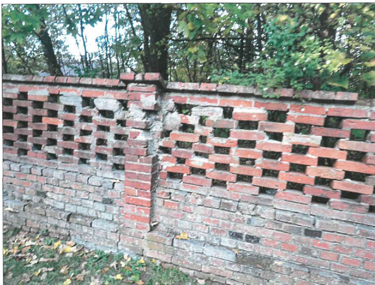
FRAGMENT MURU - ODCINEK C-D. Widoczne aktywne formy biologiczne na cegle - glony i porosty. Ubytki cegieł w murze. Ślady napraw zaprawą cementową.
