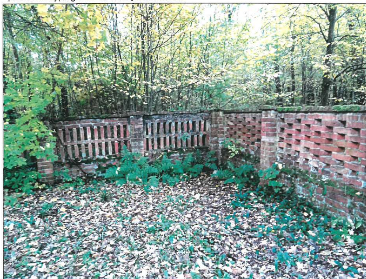
WEWNĘTRZNY WIDOK NAROŻNIKA "B" OGRODZENIA. Aktywne formy biologiczne na cegle w postaci glonów i mchów.
