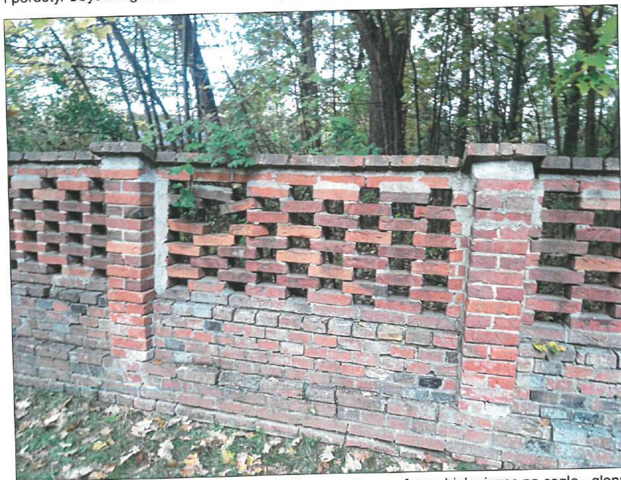
FRAGMENT MURU - ODCINEK B-C. Widoczne aktywne formy biologiczne na cegle - glony i porosty. Ubytki cegieł w murze. Ślady napraw zaprawą cementową.
