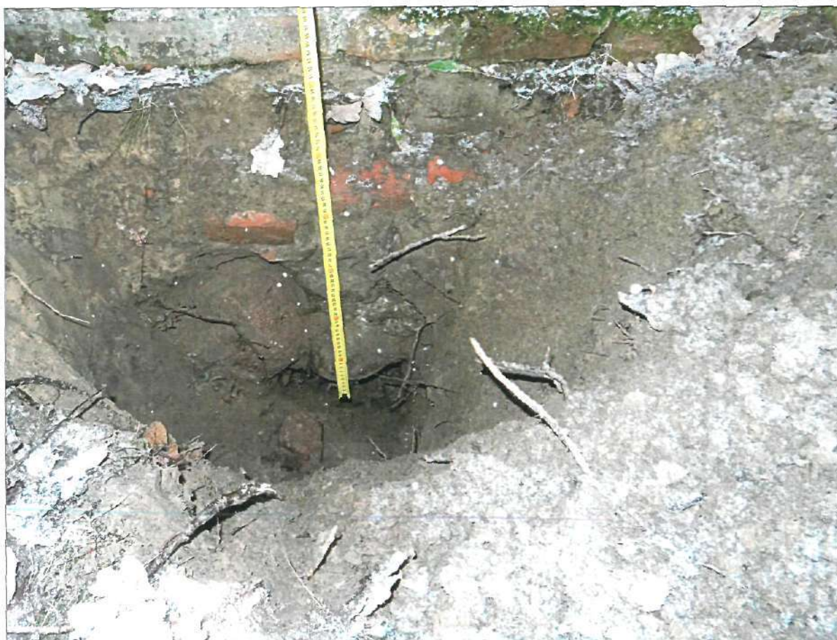
ODKRYWKA FUNDAMENTU PRZY NAROŻNIKU D. Głębokość fundamentu - ok..40 cm.
