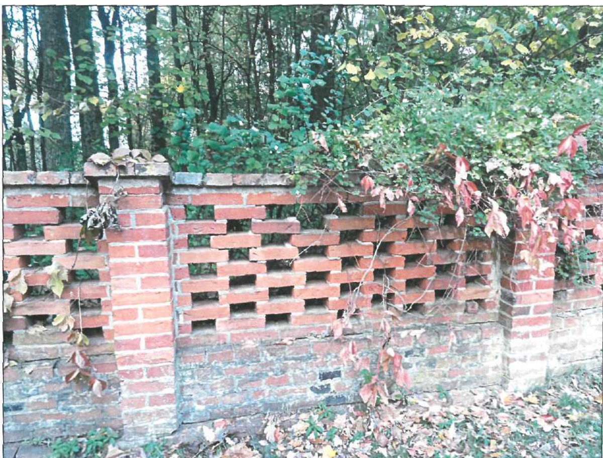
FRAGMENT MURU - ODCINEK C-D. Widoczne aktywne formy biologiczne na cegle - glony i porosty. Ubytki cegieł w murze.
