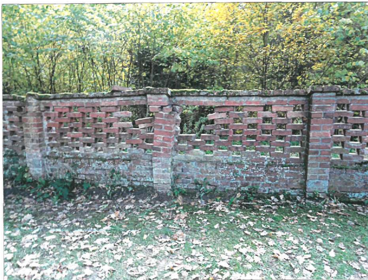
KOLEJNY FRAGMENT MURU - ODCINEK B-C. Widoczne aktywne formy biologiczne na cegle - glony i porosty. Znaczne ubytki cegieł w murze.
