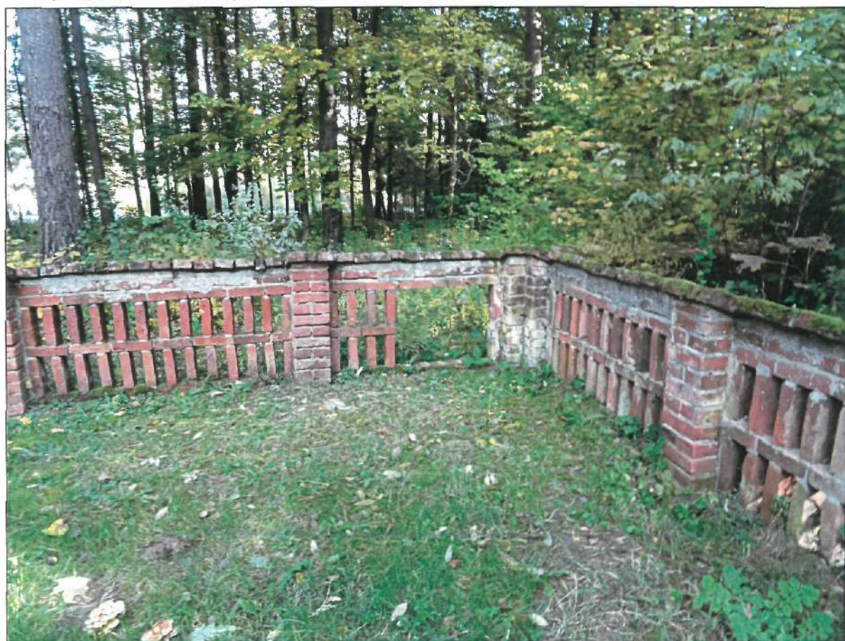
WEWNĘTRZNY WIDOK NAROŻNIKA "A" OGRODZENIA. Widoczne ślady napraw muru zaprawą cementową. Aktywne formy biologiczne na cegle. Ubytek cegieł w przęśle. Podniesiony poziom terenu od strony cmentarza.
